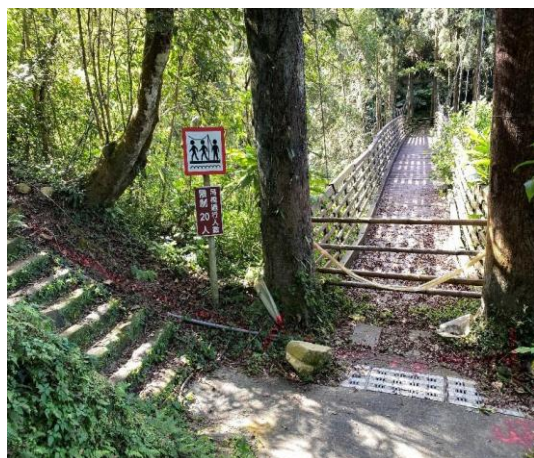
沈剛伯吊橋拆除前
