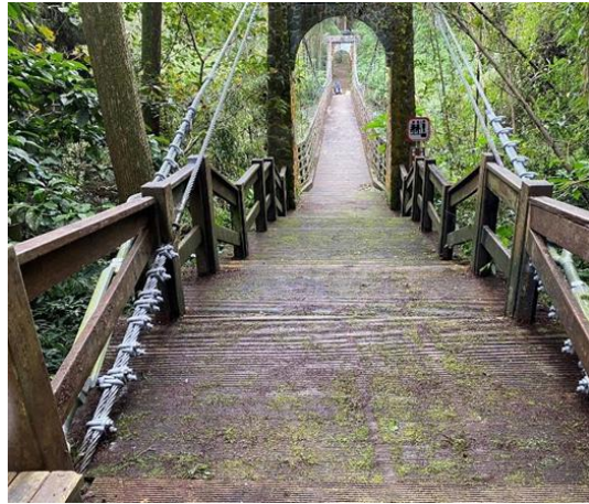
翠虹橋施工後
