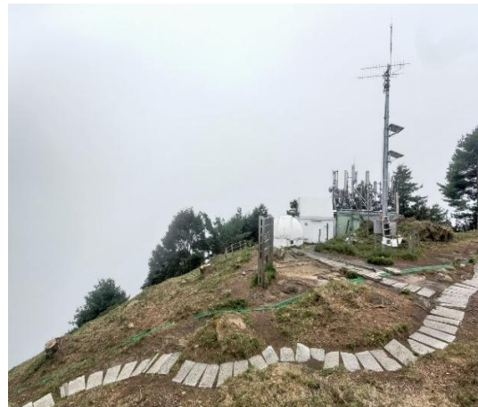
對高岳營林區31林班鹿林天文臺區域防火線建置情形
