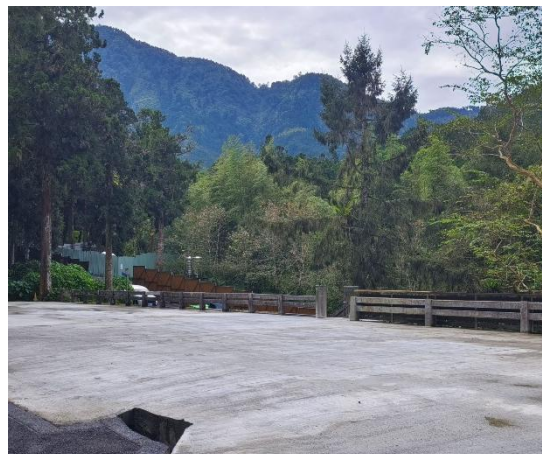
森林生態展示中心拆除後
