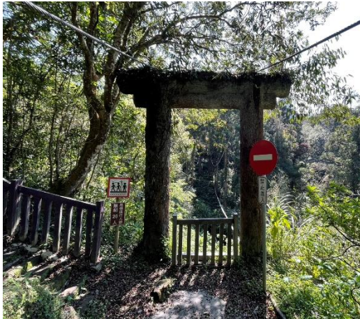
沈剛伯吊橋拆除後
