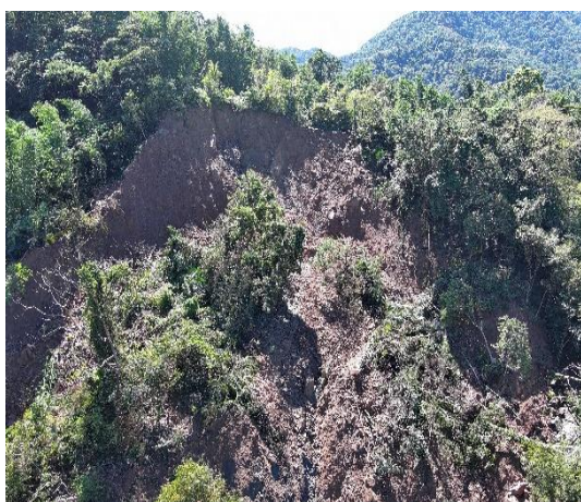
清水溝營林區「9林班線浸林道2.5K便道開設搶通作業」施工前
