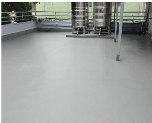
竹山辦公大樓陽臺防水工程施工後
