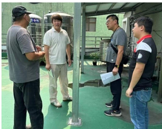
竹山辦公大樓陽臺防水工程施工前 協調會
