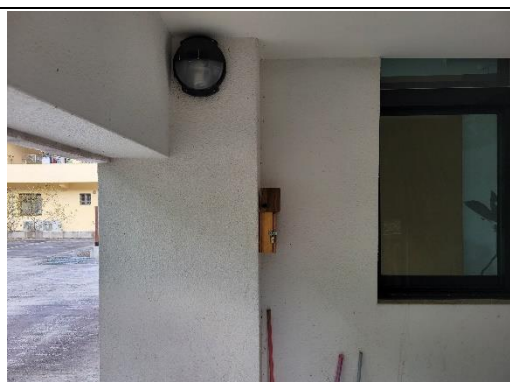
進入後巡邏箱即在左邊牆面上
